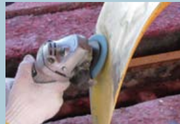
電動ディスクサンダーにペーパーディスク(#60~80推奨)を装着し研磨
