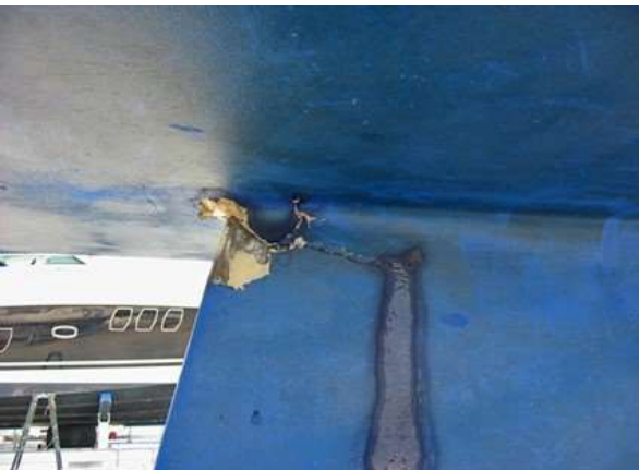
座礁バラスト修理
