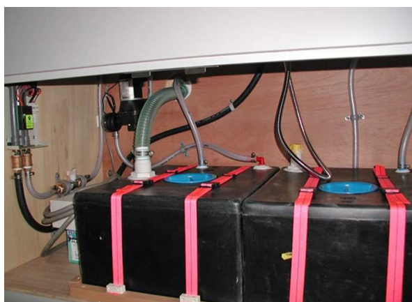
水廻り配管工事
